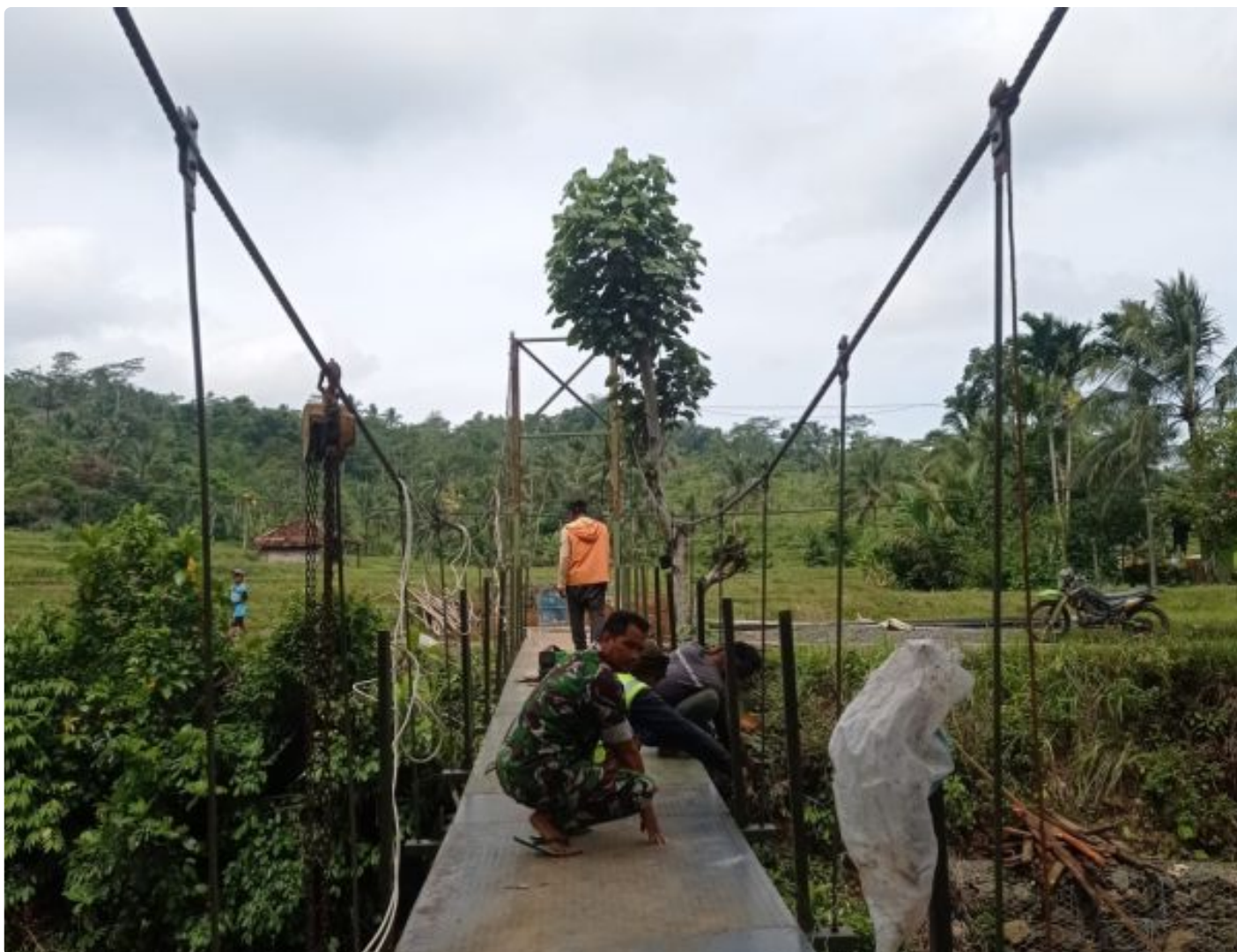
Kpt Arm Witono: Pengerjaan Jembatan Gantung Sudah 80%
